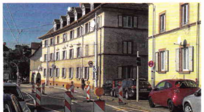
Um zwei kommunale Mietwohnhäuser und die Frage „Neubau oder Sanierung?“ ging es in der jüngsten Sitzung des ATU. Foto: Stadt
