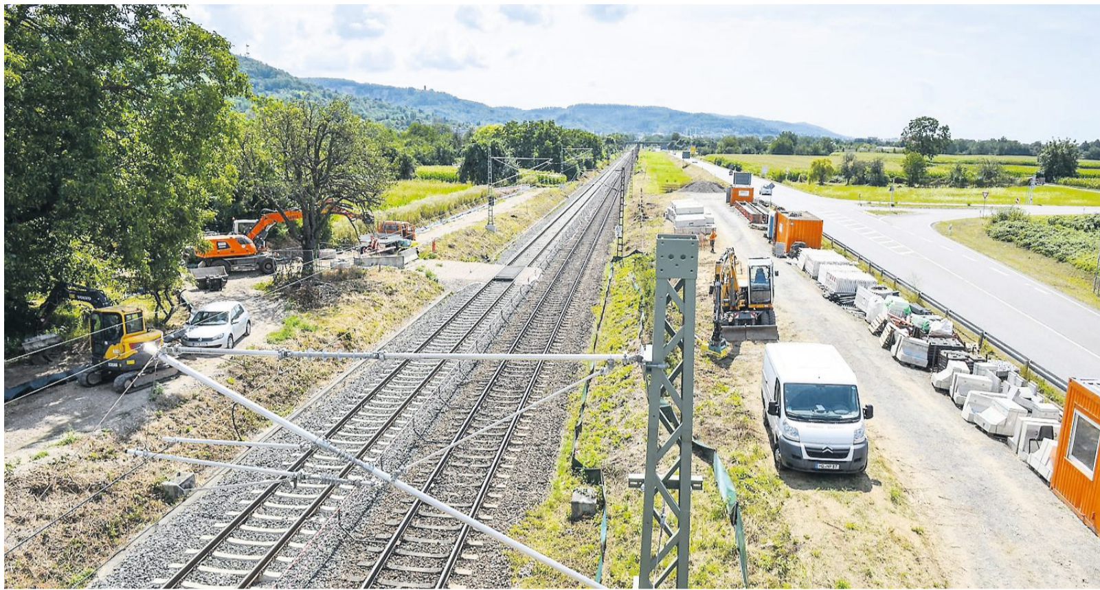
Der Baubeginn für den S-Bahn-Halt Sulzbach zeichnet sich ab, wie der Blick von der Dammweg-Brücke gestern zeigte. Auf der KVS-Seite (rechts), wo später die Haltestelle für das Gleis Richtung Mannheim sowie der Park&Ride- und der Bike&Ride-Parkplatz der Stadt entstehen, liegt bereits Material. Auf der anderen Gleisseite arbeitete der Bagger. BILD: THOMAS RITTELMANN
