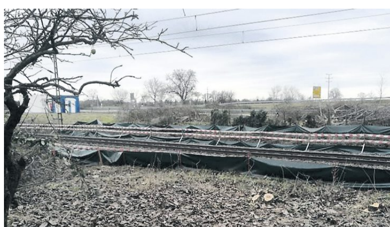
Vollendete Tatsachen: Der Besitzer eines an die Bahnstrecke angrenzenden Grundstücks traute seinen Augen nicht, als eine Baufirma im Februar im Zuge erster Baustellen-Erkundungen Bäume gefällt und Rohre gelagert hatte. BILD: PRIVAT
