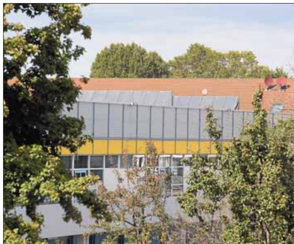
Auf dem Dach der Dietrich-Bonhoeffer-Schule gibt es Fotovoltaikanlagen. Angesichts der aktuellen Stromvergütung rechne sich das bei Schulen aber nicht mehr, so die Stadt. F.: Kreuzer
