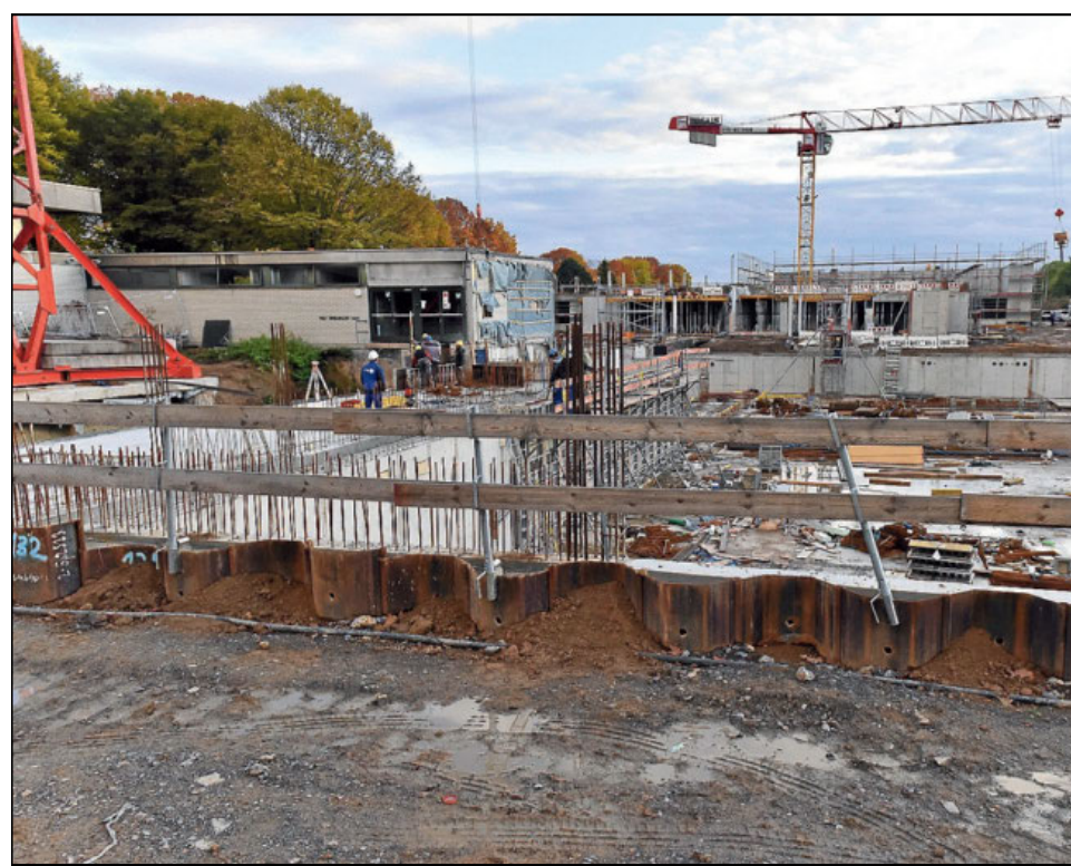
Die GAL will Fotovoltaikanlagen auf dem Dach des künftigen Schulzentrums West. Foto: Dorn
