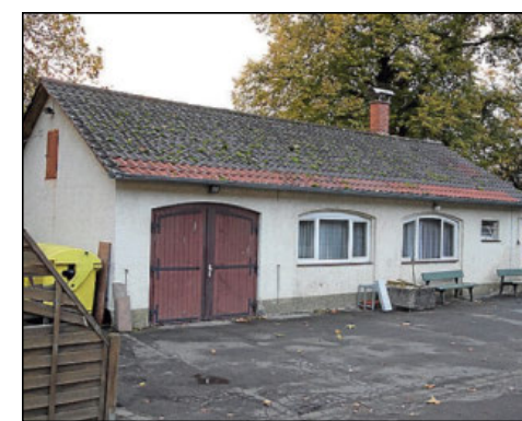
Nicht mehr zeitgemäß: Das (noch) bestehende Betriebsgebäude. Foto: Kreuzer
